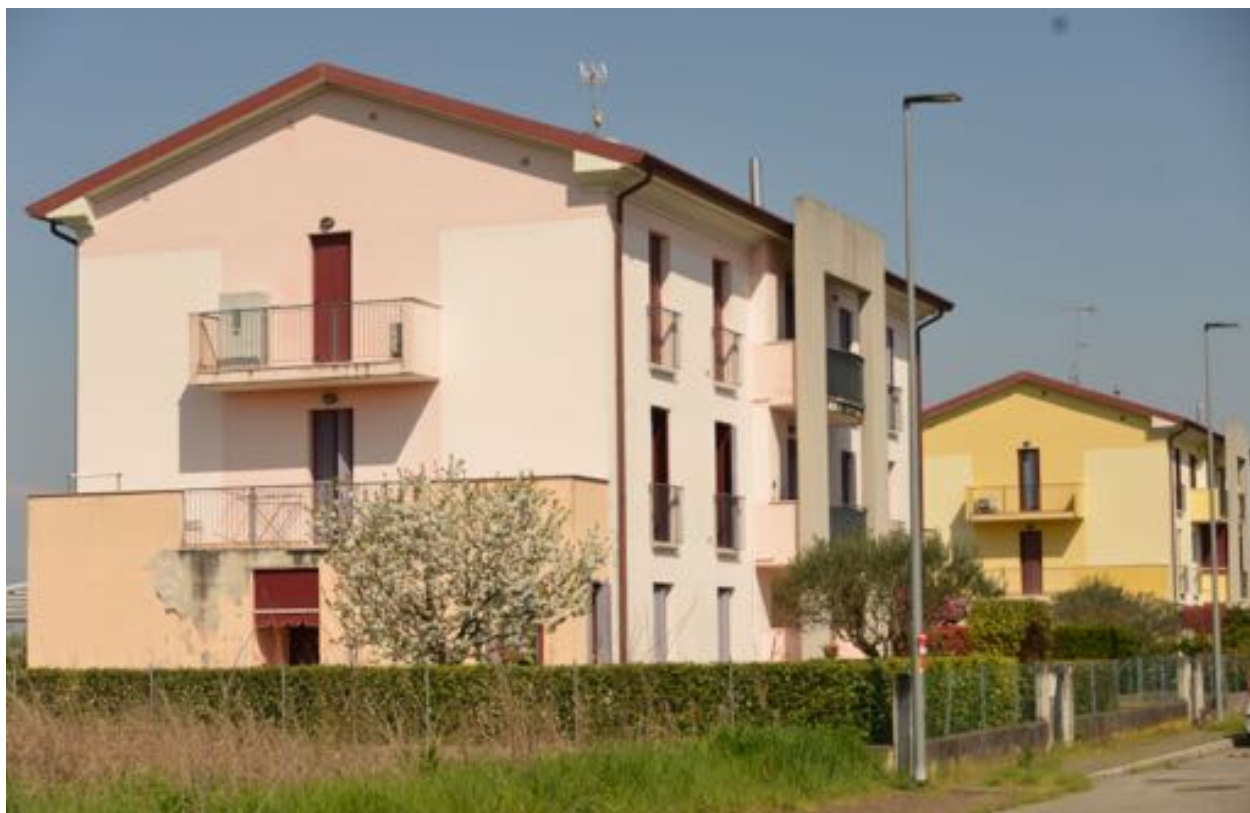
Foto n. 11 – Fronte sud- est
