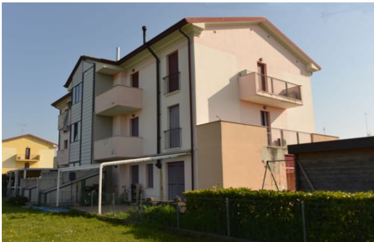
Foto n. 9 – Fronte sud- ovest
