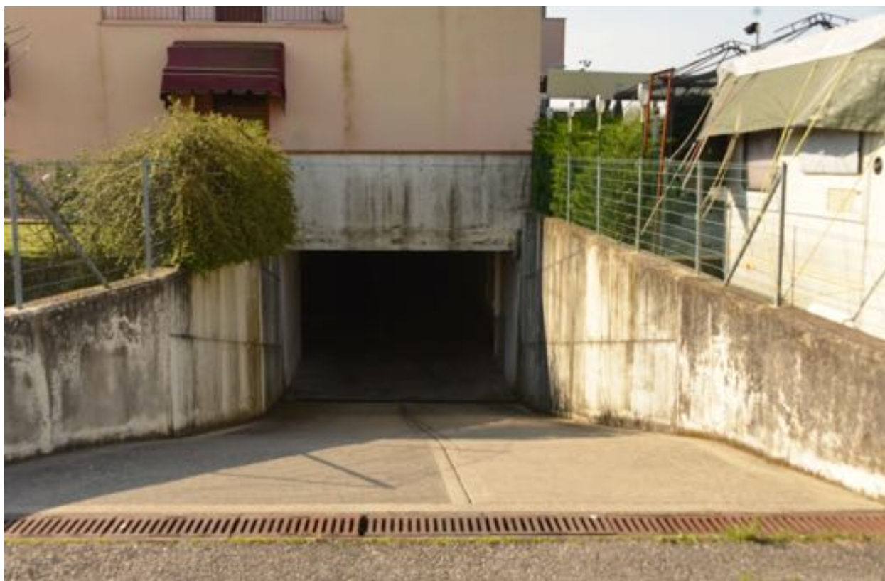
Foto n. 36 - Rampa di accesso ai garage al piano interrato
