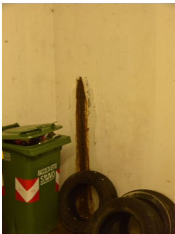
Foto n. 40 – Particolare infiltrazione
