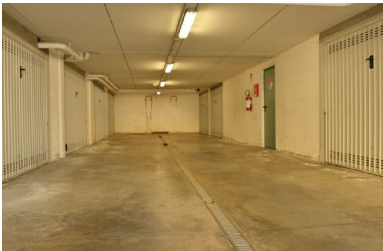
Foto n. 37 – Area di manovra interrato
