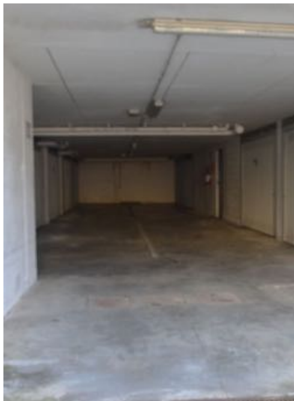
Foto n. 35 – Piano interrato - garage
