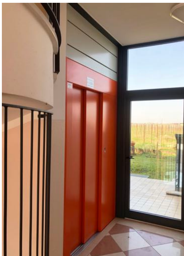
Foto n. 20 - Androne piano terra - ascensore
