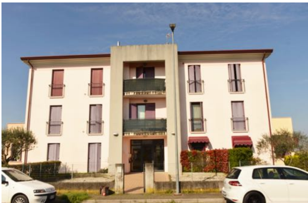
Foto n. 7 – Fronte est su Via Teresa da Calcutta
