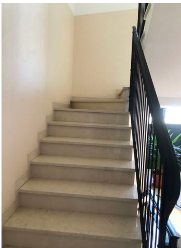
Foto n. 21 – Particolare scala condominiale
