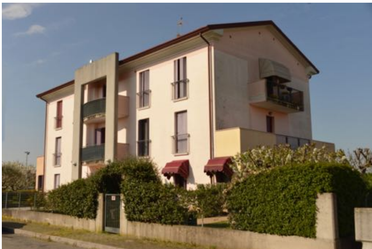
Foto n. 1 – Fabbricato da Via Teresa da Calcutta – Fronte nord-est
