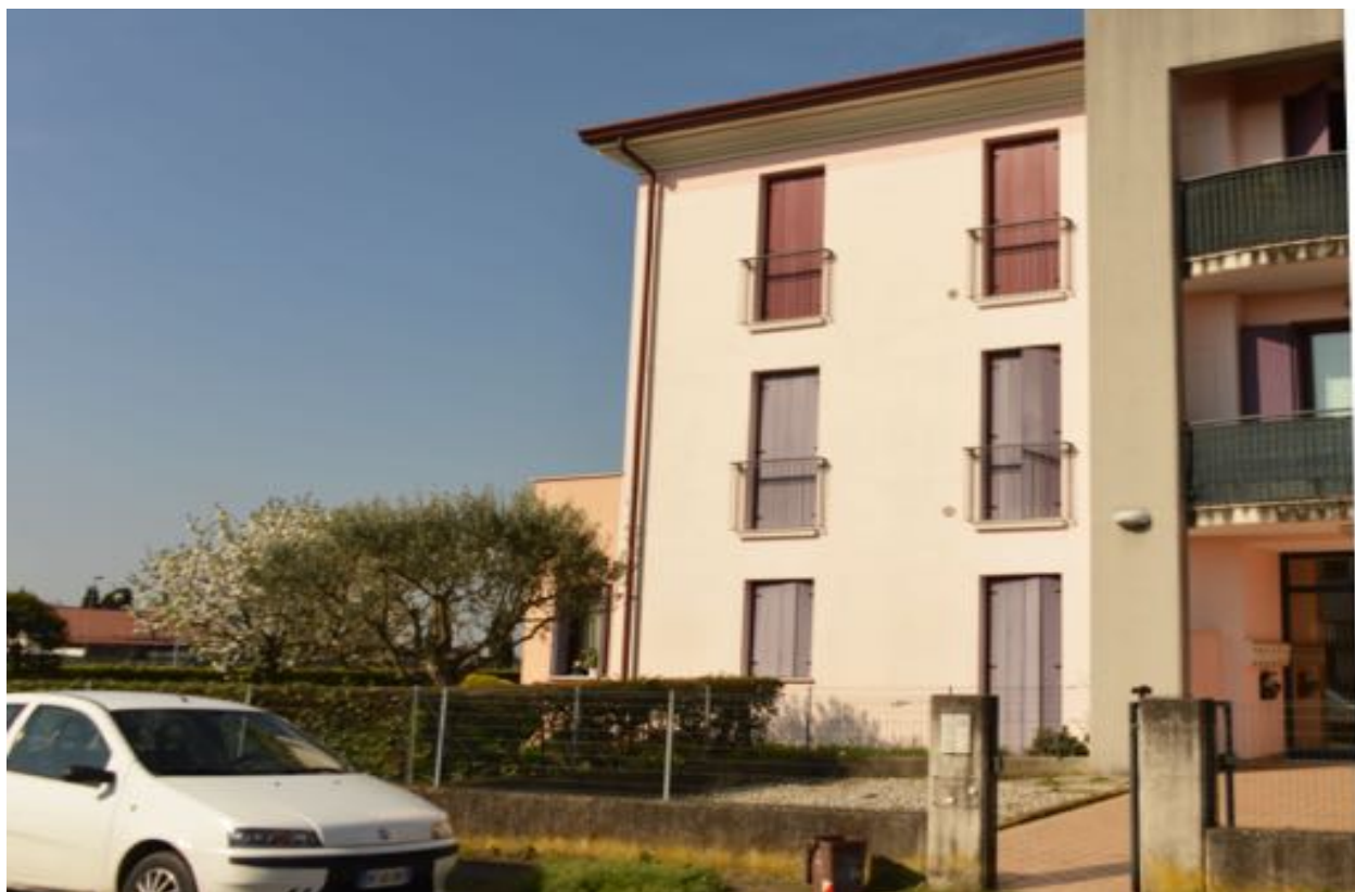
Foto n. 8 – Fronte est su Via Teresa da Calcutta
